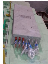
コンクリート打設後(P6)
