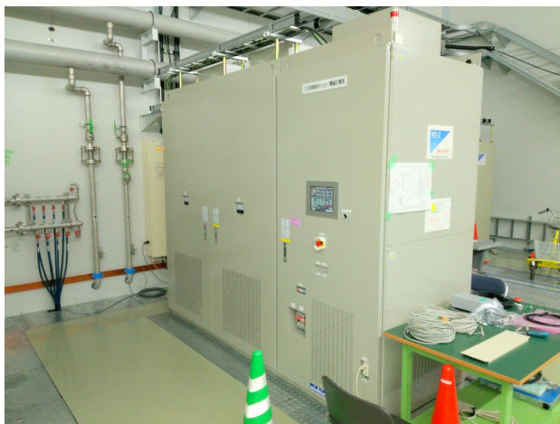
パルス電源 (60 Hz, 1 kV-299 A)
