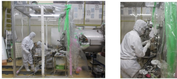
簡易クリーンブース(class 5程度)を用意。 空洞とゲートバルブ接続
