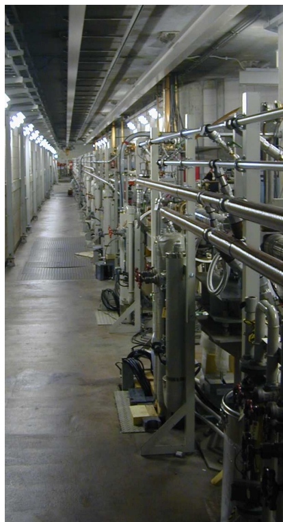
図 1. 改修前 (左) と改修後 (右) の電子リニアック室。改修で新設された 4 本の配管は、加速管の温水と RF 窓・ダミーロードの冷却水配管であり、加速管の横に設置することにより、配管長及びポンプの揚程を最小限にした。
