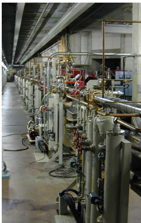
図 1. 改修前 (左) と改修後 (右) の電子リニアック室。改修で新設された 4 本の配管は、加速管の温水と RF 窓・ダミーロードの冷却水配管であり、加速管の横に設置することにより、配管長及びポンプの揚程を最小限にした。
