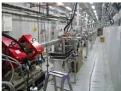
図3 リニアック室現状。パンチャー出口から下流側を撮影。
