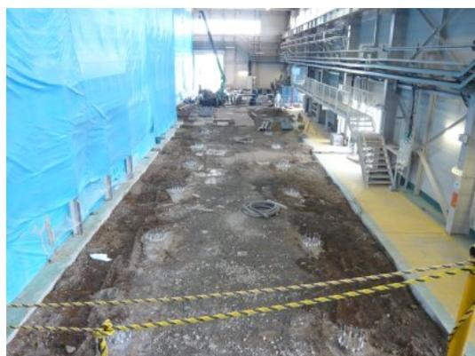
写真3 : ATF2ビームライン予定部。上流からビームダンプ方向。床補強工事は9月末まで、10月からビームラインの設置を開始。
