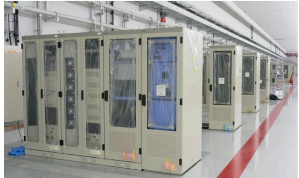
図2: C-band部4連ラック(左2連の水冷式に電磁石電源が收容される)
