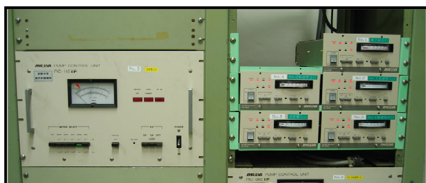
図 3 左側：旧イオンポンプ電源 (専用大型) 右側 5 台：新イオンポンプ電源 (小型汎用)
