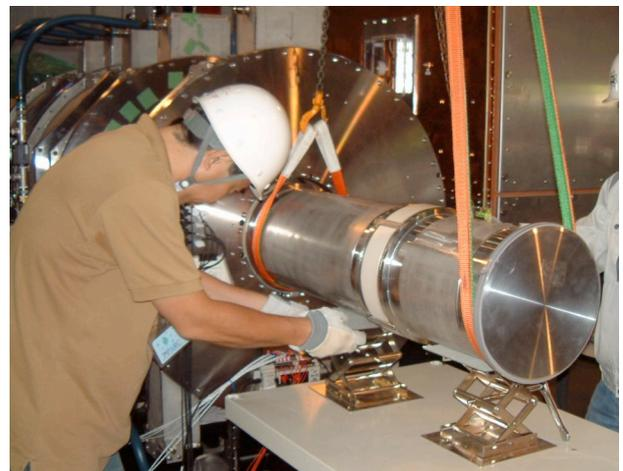
図 2 : 実機ビームパイプの差し込み引き抜き作業
