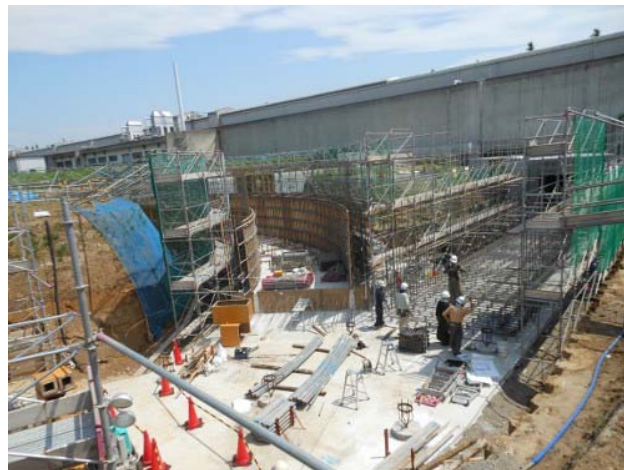
図6：ダンピングリング建設風景
