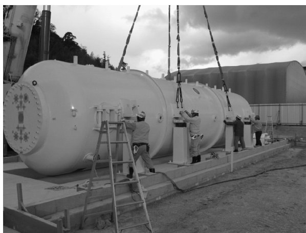
図 1: 加速器タンクの設置。2012 年 2 月 18 日撮影。
