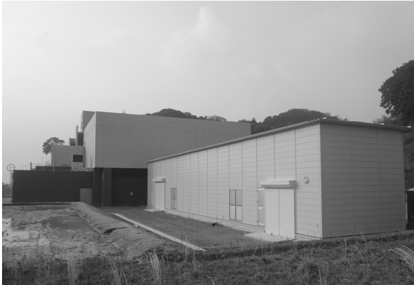
図 2: 仮設タンデム加速器棟 (プレハブ棟) の外観。プレハブ棟の向こうに FFAG 加速器棟が見える。2012 年 3 月 11 日撮影。
