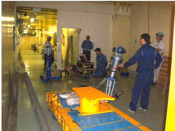
図 8 : 搬入棟とトンネルを結ぶ搬入通路のモニタリングの測量
